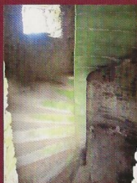
Escalier à vis en pierres de schiste
