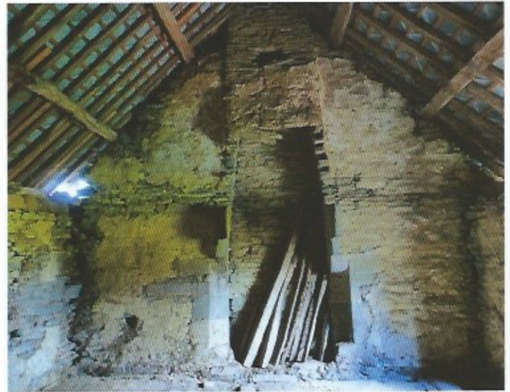
En haut : cheminée de la chambre haute de l'aile arrière.
