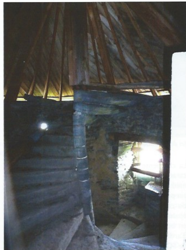
Le sommet tronqué de l'escalier, il devait conduire à second étage, probablement un comble au-dessus du premier étage disparu.
