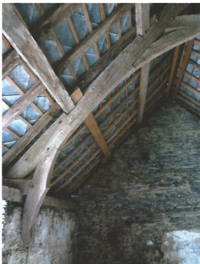
Une autre vue de la charpente de l'aile arrière.
