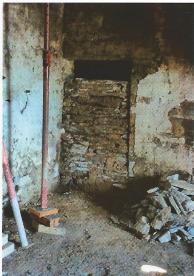
À gauche de la cheminée de la grande salle le piquage de l'enduit fait apparaître une porte murée...
