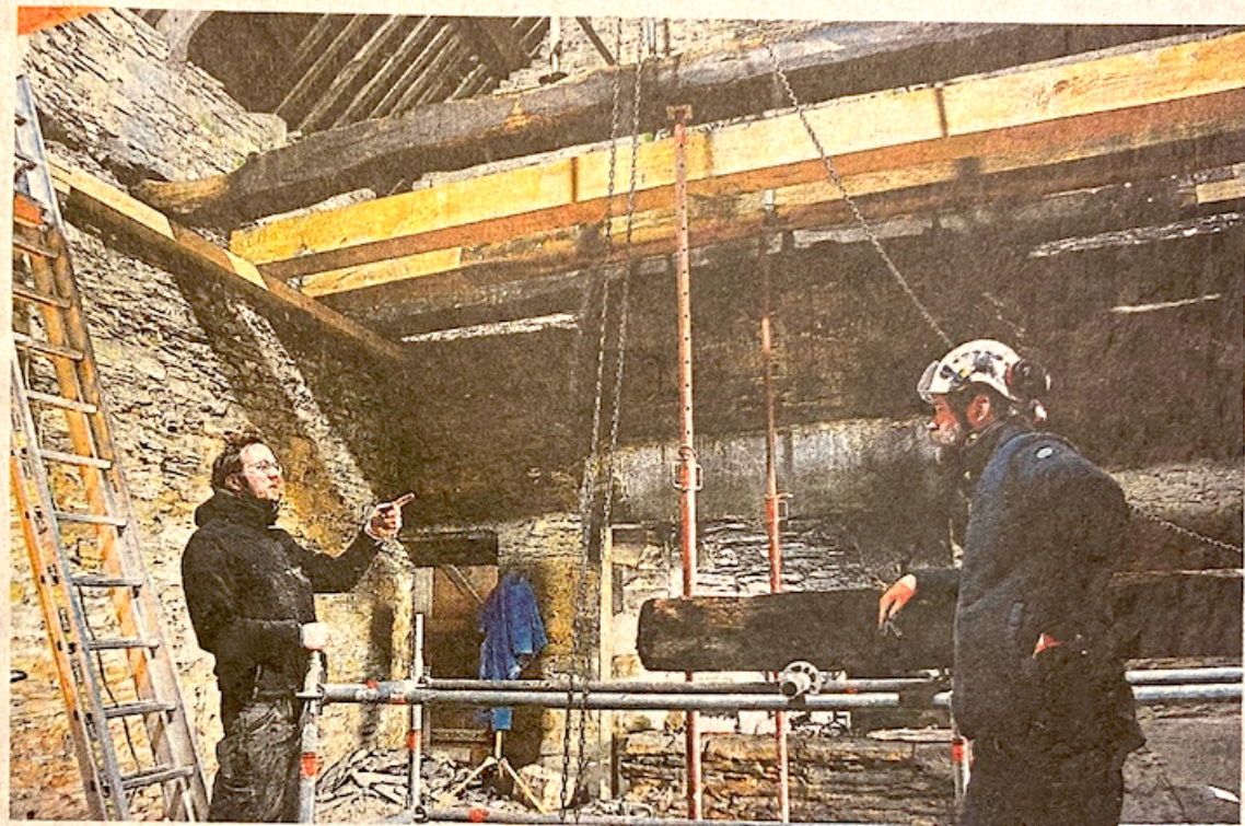
Les charpentiers pausent les poutres dans leurs emplacements d'origine au manoir de la cour de Launay.
