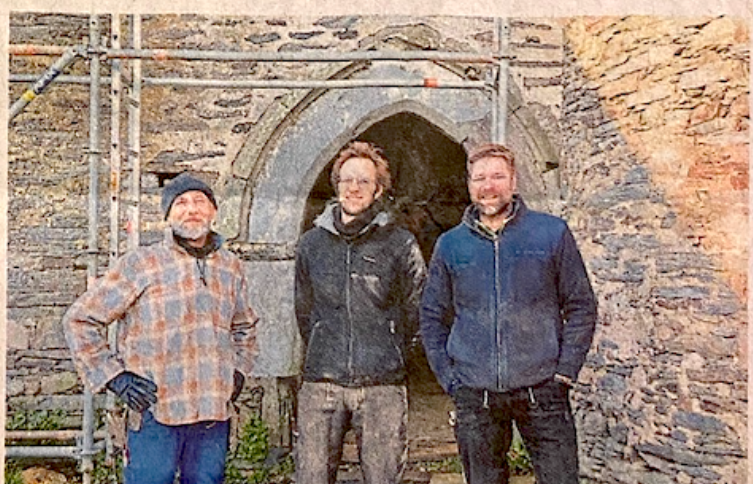
Les trois charpentiers ont monté les poutres à l'ancienne à l'aide d'un treuil.
